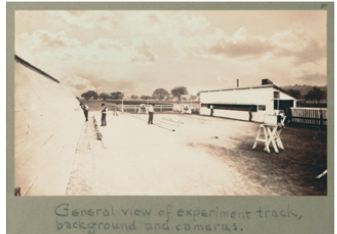
Muybridges Anlage in Palo Alto, 1879. In dem Gebäude auf der rechten Seite des Bildes sind die Kameras untergebracht. Auf der linken Seite ist eine weiße Wand zu sehen, vor deren Hintergrund die Pferde in ihrem Bewegungsablauf abgelichtet wurden.
